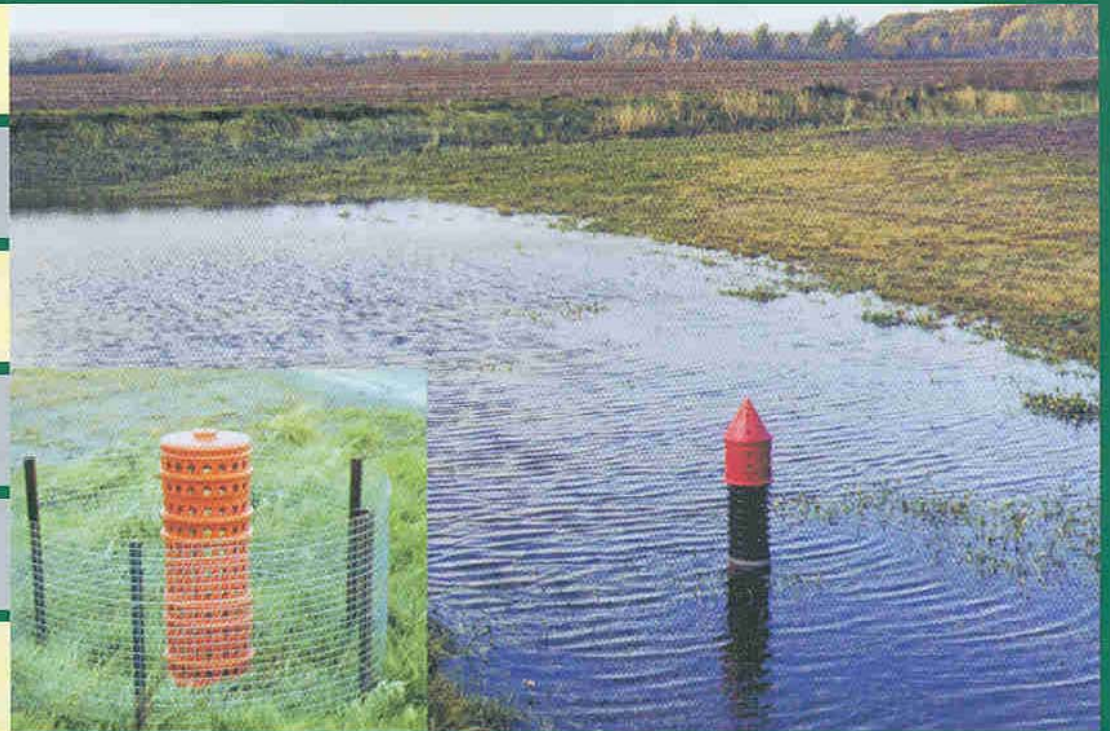
Avaloir et bassin de sédimentation
